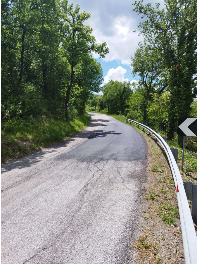
FOTO 1 - S.P.N.2 “CONCA” KM 15+900 – ante intervento e post intervento
