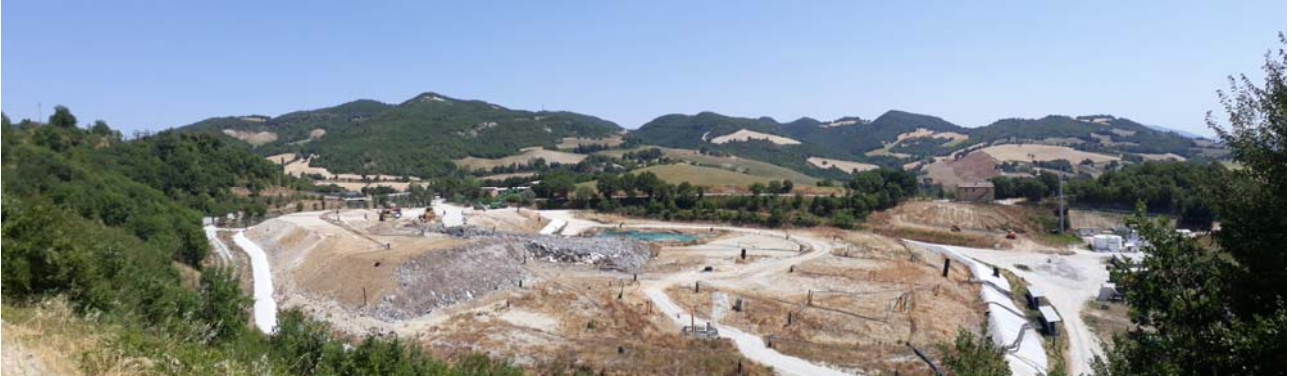
Figura 1: Vista dell'impianto da Sud Ovest
