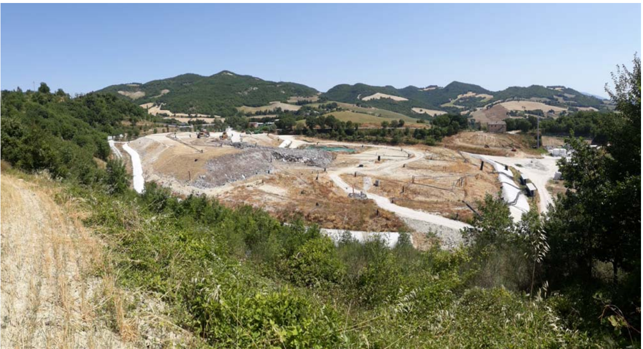
Figura 2: Vista dell'impianto da Sud Ovest
