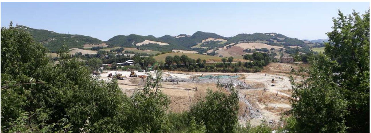
Figura 7: Vista dell'impianto da Est
