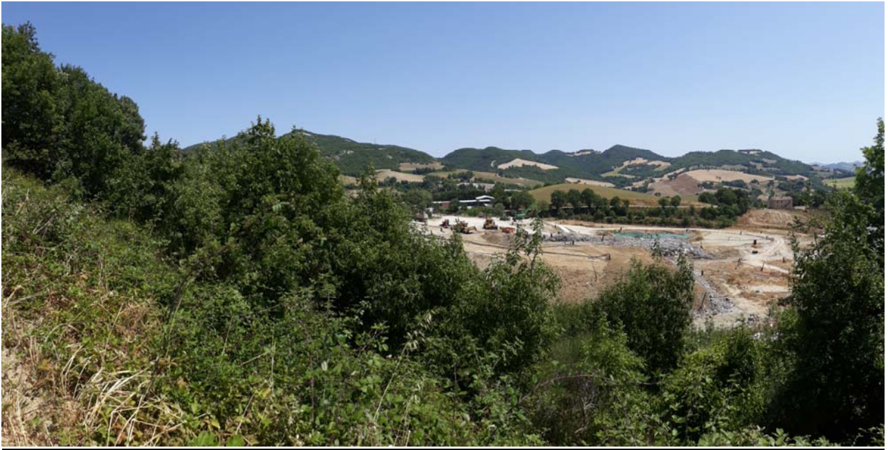
Figura 6: Vista dell'impianto da Est
