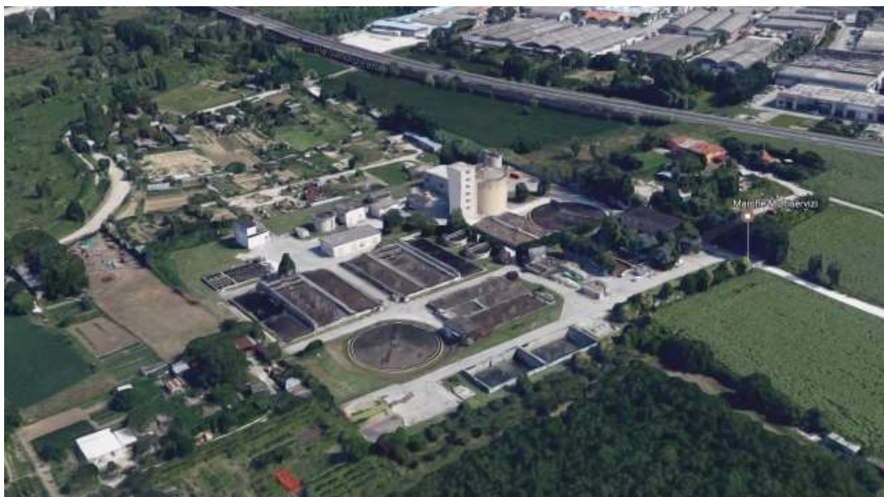
Figura 20 configurazione attuale dell'impianto
