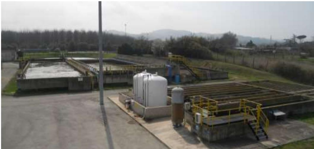
in primo piano, sulla destra, clorazione linee A, B, D; dietro pre-denitrificazione, nitrificazione e sedimentazione secondaria linea B
