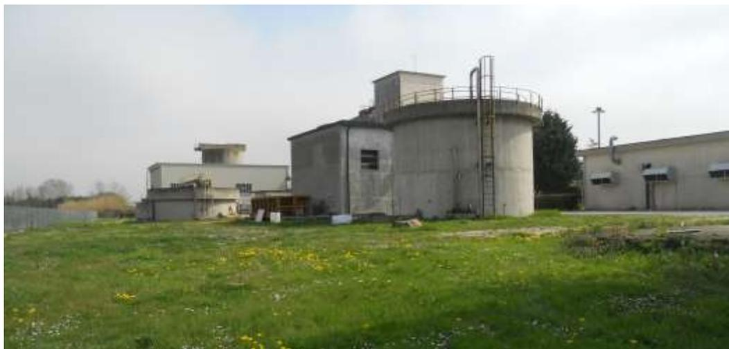
Vasca di stabilizzazione aerobica (al centro); sulla destra il locale soffianti linea A, B, C, sulla sinistra il post ispessimento e dietro il locale disidratazione meccanica
