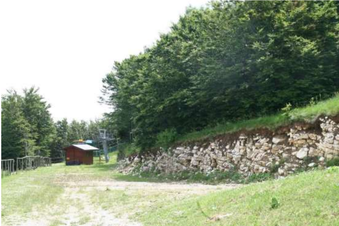
Fig. 11 – Area dove attualmente è collocata la scivola OS21 e che verrà sostituita dal sostegno di linea AV e R1. Affioramento di strati di calcare micritico della Formazione Corniola
