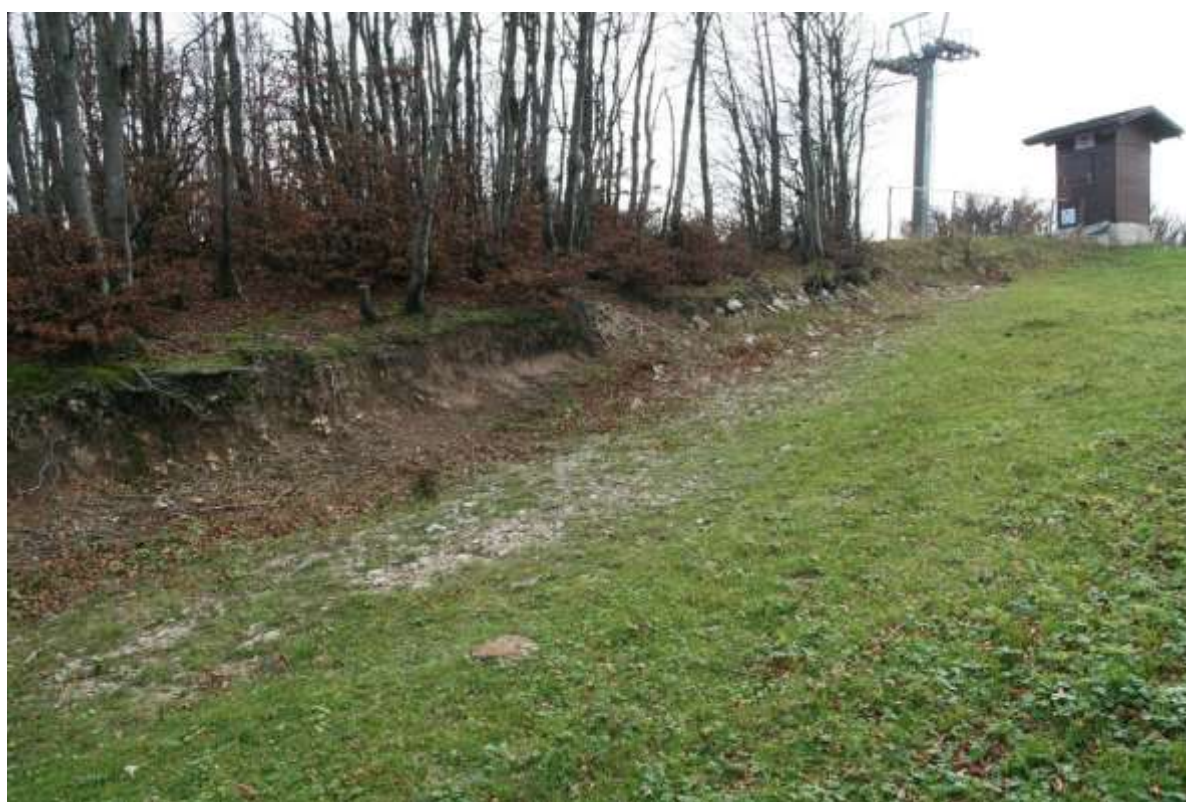
Fig. 16 – Tratto finale del tratto di sostituzione con Seggiovia OS21, in corrispondenza dell'arrivo. Visibile la formazione alterata dei Calcari Diaspri
