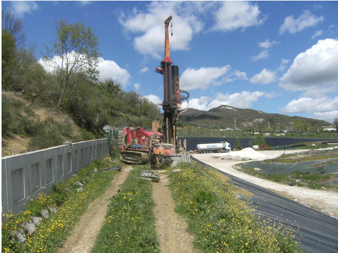
FOTO 7 :Ubicazione sondaggio S10
