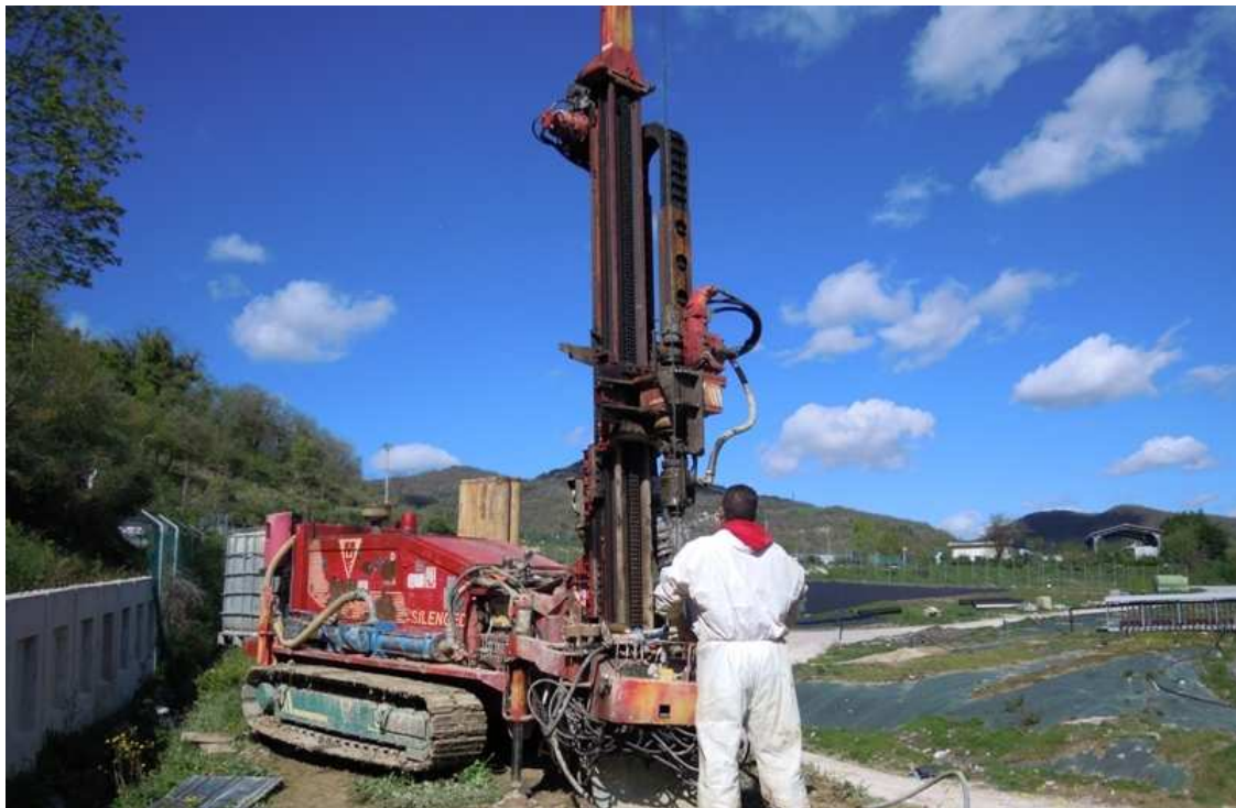
FOTO 8 :Ubicazione sondaggio S10
