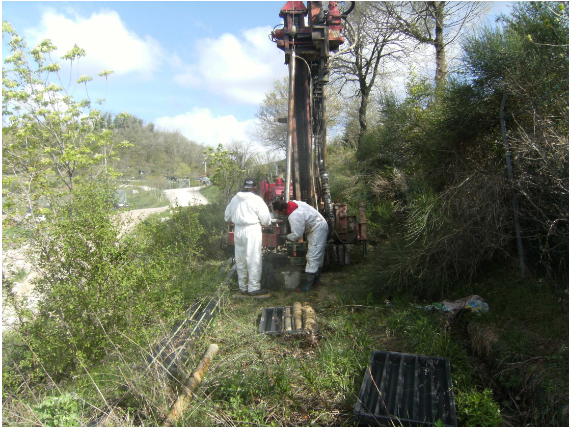
FOTO 1 :Ubicazione sondaggio S9
