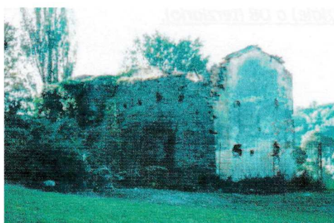
Foto anno 2004 - Lato nord-ovest
