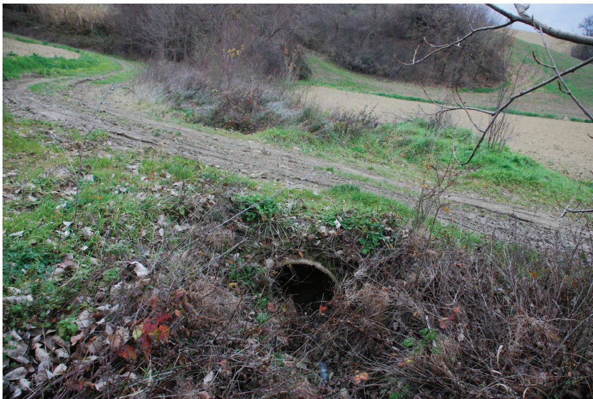
SETTORE DELL'IMPLUVIO INTUBATO POSTO LUNGO LA STRADINA D'ACCESSO AI CAMPI A DESTINAZIONE AGRICOLA (DIAMETRO 60 CM)
