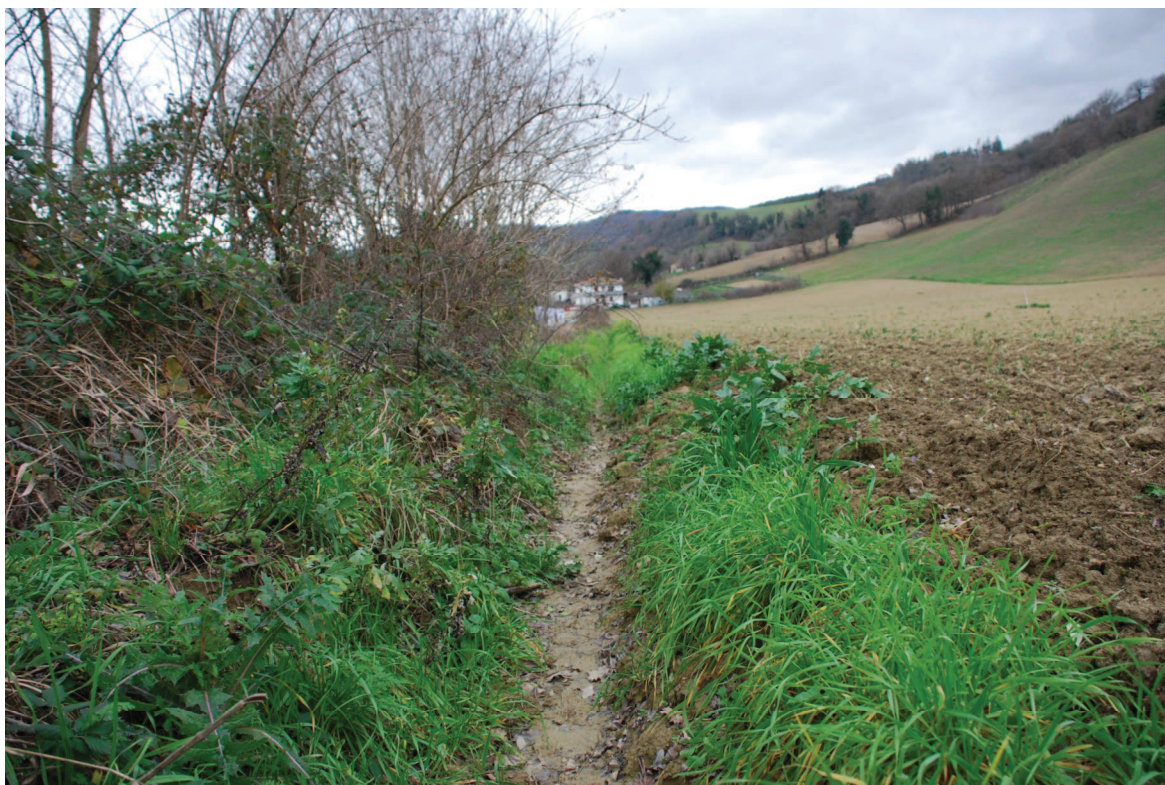
FOSSO DI GUARDIA SECONDARIO POSTO A RIDOSSO DELL'AREA
