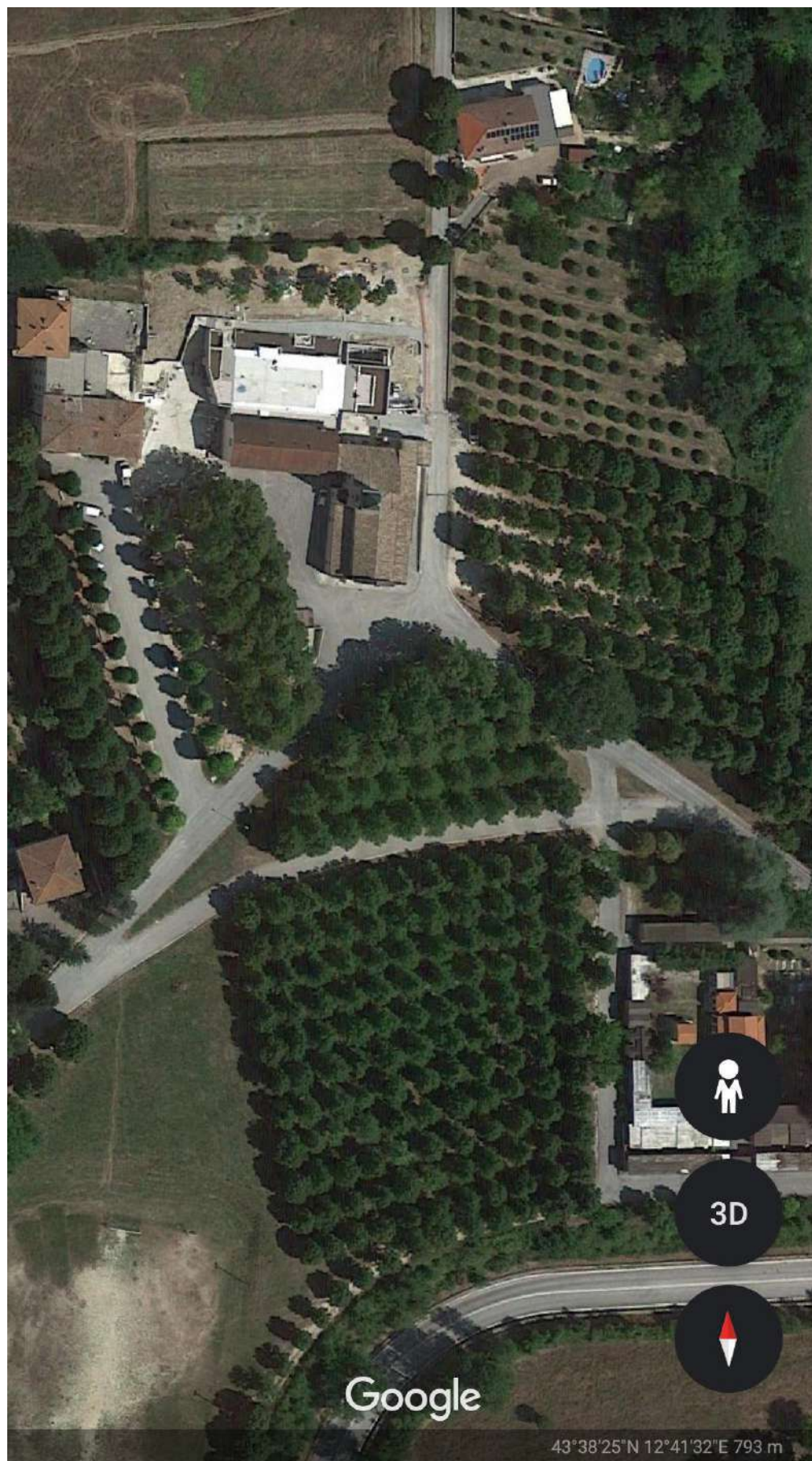
Esempio 1: Acqualagna (PU), Santuario del Pelingo (foto aerea Google Earth anno 2018)
