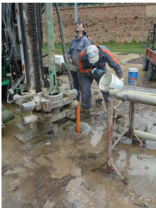
Fase installazione piezometro Pz2
