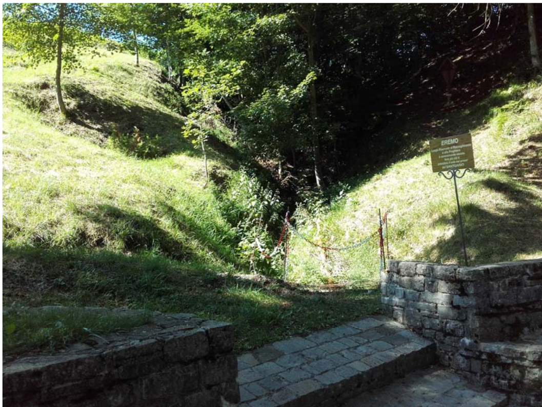
FOTO 42: Particolare sul tratto in cui l'impluvio presente ad Est dell'Eremo è interessato da tombinatura.
