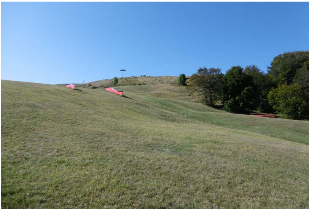
FOTO 22: Ripresa sulla parte mediana dell'area indagata, vista da Nord-Est. Si osservano le irregolarità topografiche rilevate. Nella parte destra sono riprese due delle essenze arboree ritenute significative nell' analisi fotogeologica multitemporale comparata .
