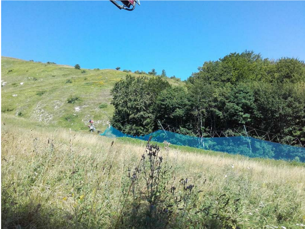
FOTO 37: Ripresa sulla parte medio bassa della scarpata che si sviluppa a monte dell'Eremo, vista da Est. Si osservano gli effetti dei rimodellamenti più recenti.
