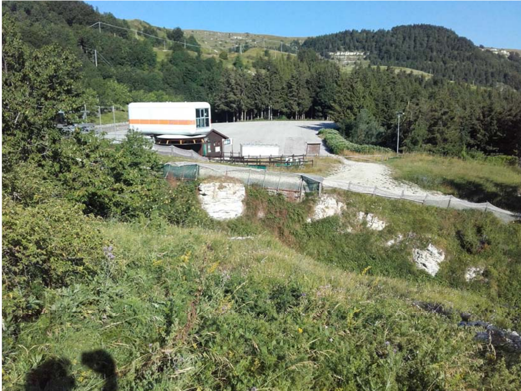
FOTO 5: Ripresa sull'impluvio posto più a Nord-Est nell'area indagata, ad Est del parcheggio. Si osservano le scarpate in parte erosive incise nel substrato.
