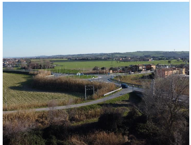
12-Vista complessiva della rotonda e dell'attacco al ponte
