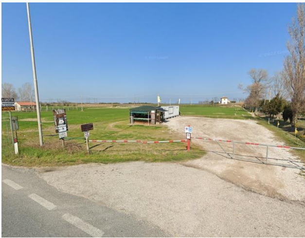
10-Vista dell'area dove verrà realizzato il parcheggio
