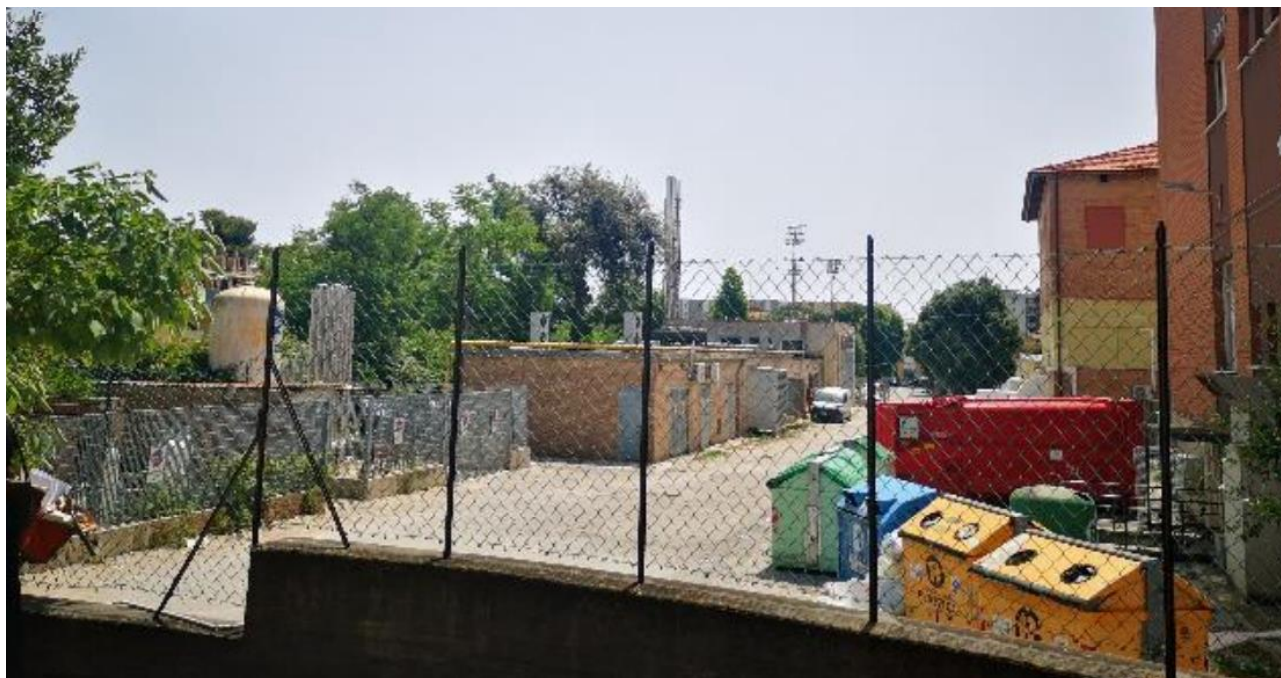
Figura 7 - Vista, dall'interno dell'area ospedaliera, del confine con l'adiacente area "a verde". Sono presenti: isola ecologica, deposito gas medicali e centrale termica.
