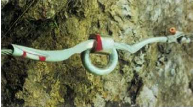
Figura 1.2: Particolare di un ancoraggio alla parete rocciosa
