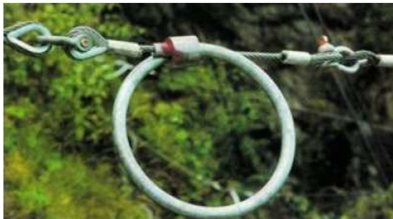
Figura 1.3: Particolare di dissipatore di energia ad anello
