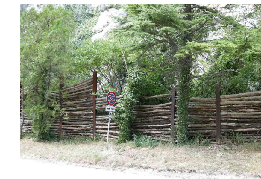
Immagini di alcune barriere paramassi in legno da ripristinare.
