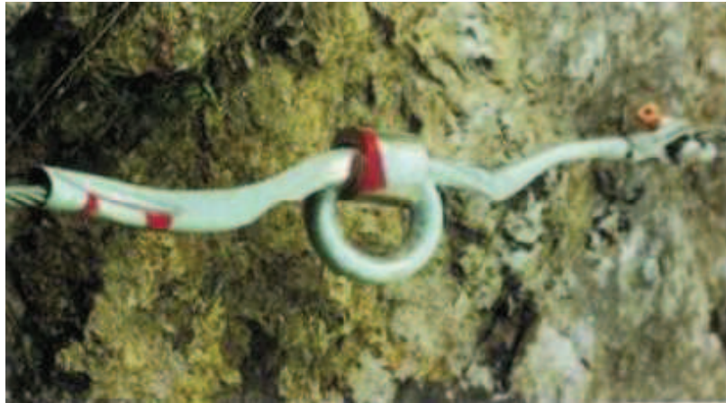
Figura 1.2: Particolare di un ancoraggio alla parete rocciosa
