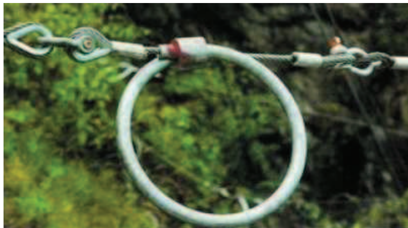
Figura 1.3: Particolare di dissipatore di energia ad anello
